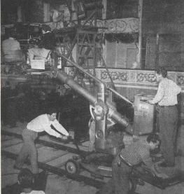
La macchina da presa montata sulla gru
