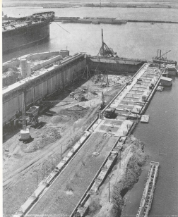
Cantiere di Sestri: in questa foto, recentemente scattata, si vede lo stato dei lavori del basile e, a, il primo in ordine di costruzione. Lo scavo interno, praticamente ultimato, è giunto a circa 8 m. sotto il livello del mare e si stanno costruendo i pilastri tiranti che, in numero di 600, ancoreranno al terreno sottostante la piazza di calcembrone armata spessa m. 5,50 che starà vinca sul fondo. La parte di sinistra del basile infatti è già quasi ultimata, mentre in quella di destra manca ancora il piano superiore di sovrastante delle gru a torre.
