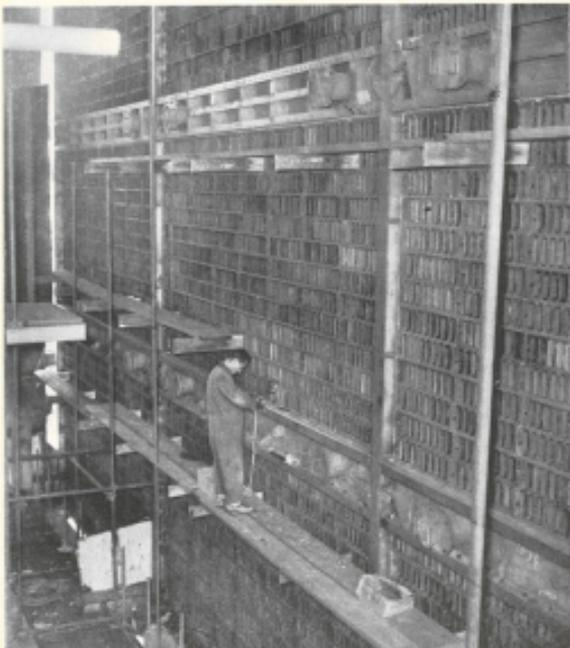
Sotto: stanza dei tubi; pareti laterali di una caldaia per la centrale S.M.E. di Napoli. A fianco: rifilatura dei tubi con i nastri cassetto del riscaldatore aria della stessa caldaia.
