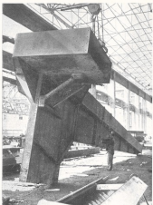
A destra: sfilata per gru a cavalletto, costruita per conto della Società «Inveco» di Milano, fotografata alla Saonazione di Valtellina mentre sta per essere capovolta
