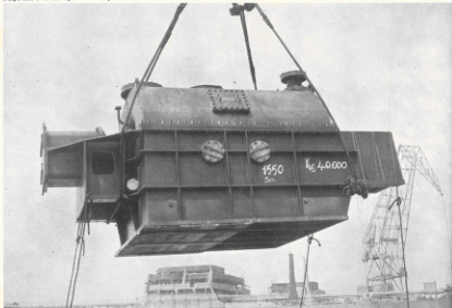
Sotto di lavoro al Cantiere di Sestri. Sopra a sinistra: blocco di prua prefabbricato della turbomarina «British Signet» di 26.380 t.d.w. in procinto di essere trasportato a bordo. Sopra a destra: particolare di una turbomarina di 32.380 t.d.w. in costruzione. Sotto: imbarco di una turbina per la «Leonardo da Vinci».
