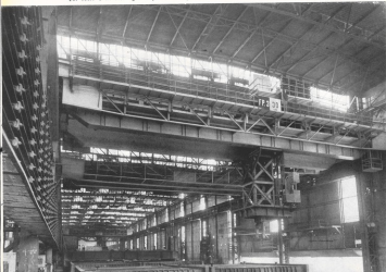
Qui sotto e in alto: gru a poma «Morgan» da 30 tonne, costruite dall'Ansaldo per l'Italsider
